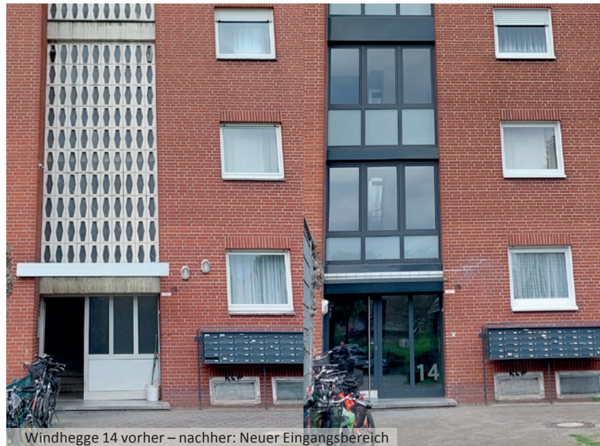
Windhegge 14 vorher – nachher: Neuer Eingangsbereich
